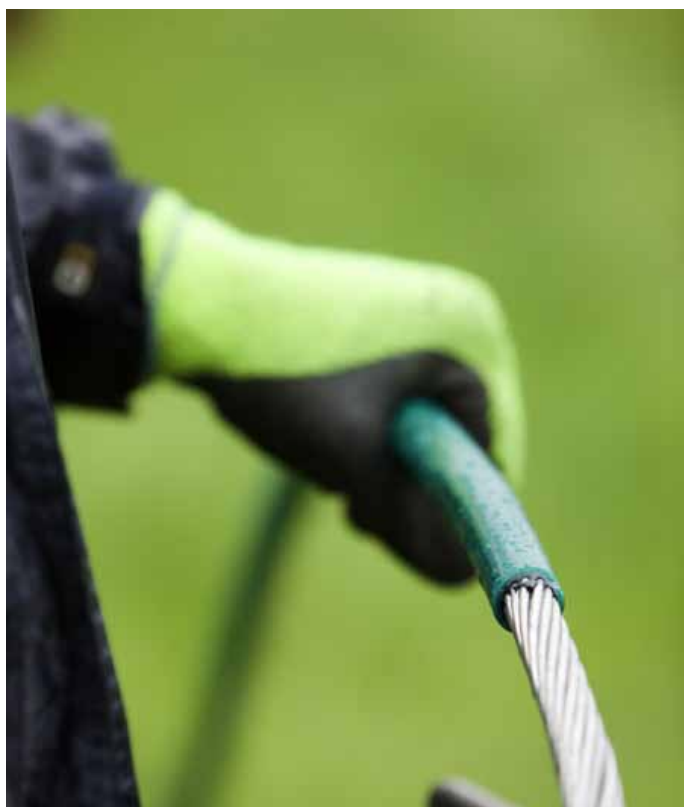
Den nya linan av typ BLL avisoleras för montering på spännlinhållaren.
