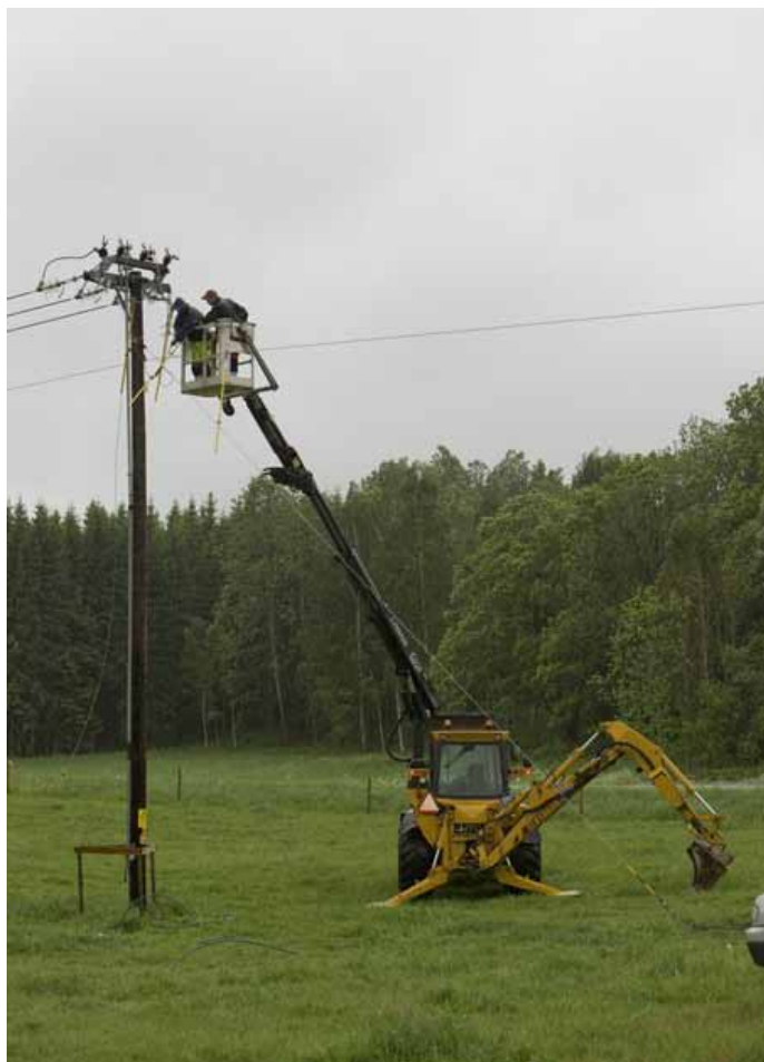
De nya belagda linorna monteras på enkelstolpen.
