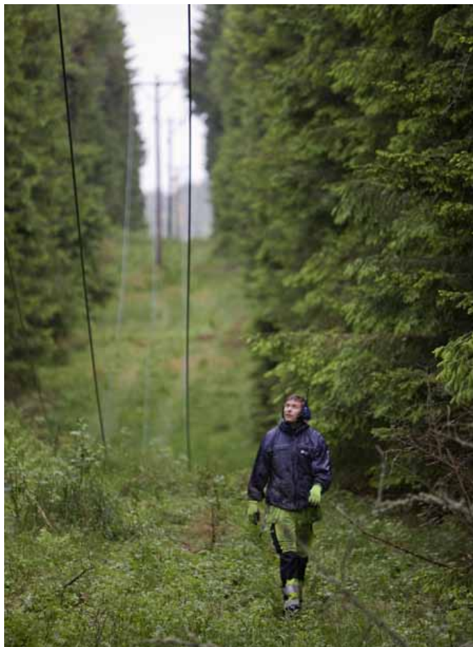
Linjemontören Marcus Karlsson synar en ledningsgata efter att två av linorna dragits ut för att senare spännas.
