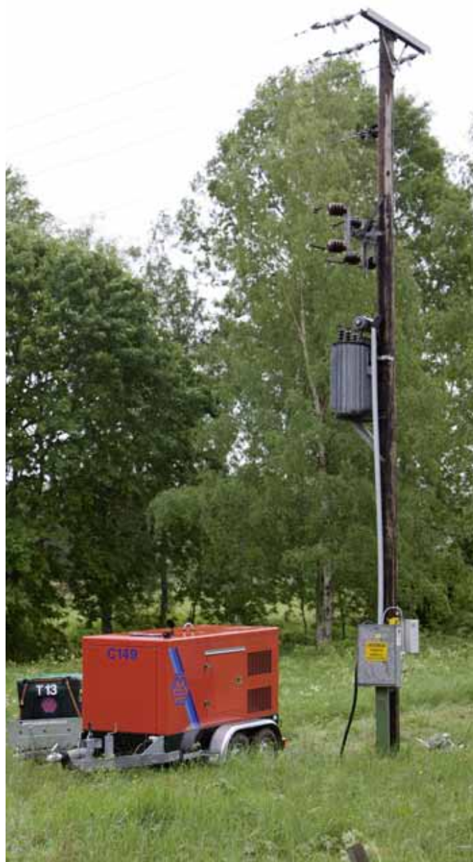
Genom mobila generatoraggregat stördes inte de boende i området av några strömavbrott under linbytet.
